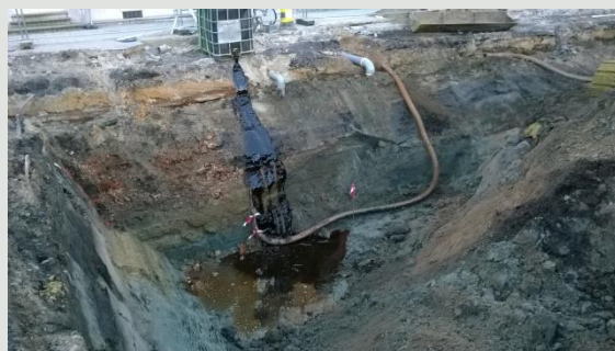
Ontgraving voor voormalige wasserij
