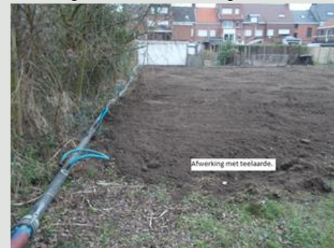
Saneringslocatie na werken
