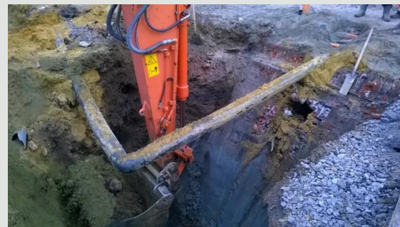
Ontgraven zone richting Voorburg
