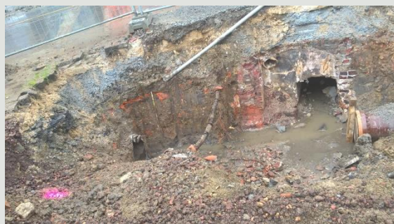
Gemetste rioleringsput richting Voorburg
