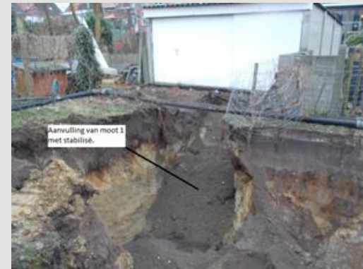
Mootsgewijze ontgraving thv garage.
