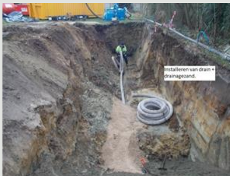
Plaatsen van drain
