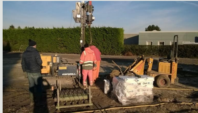
Plaatsen 71 injectiefilters
